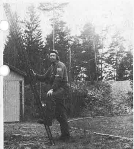
● Gösta Carlsson, på väg uppåt.
